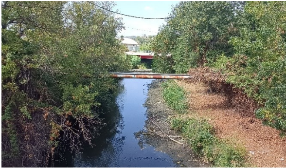
Fig 60 - Retenue en amont du seuil St-Menet (20210914)
