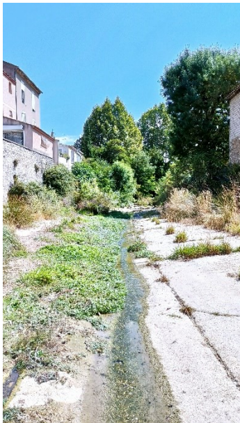
Fig 39 - Huveaune à l'entrée du centre-ville d'Auriol le 31-08-2021
