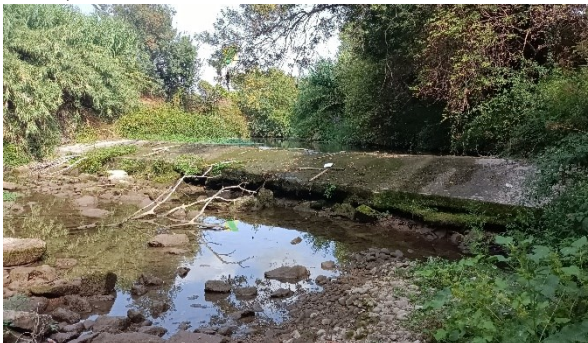
Fig 64 - Seuil Ste-Mitre le 14 septembre 2021 à 15h30
